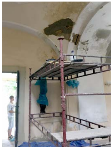
Oprava zatékajícího stropu ve Světcí
